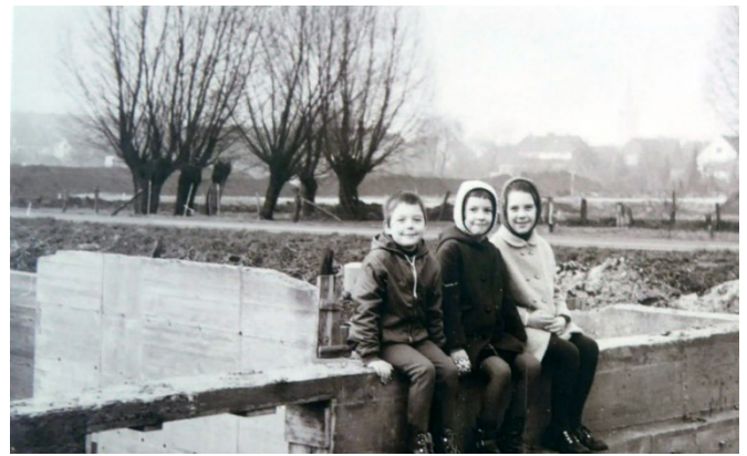
Die Friedrich-Kinder sitzen auf dem gegossenen Kellerfundament. Im Hintergrund ist erkennbar, das Mommenpesch und die von-Harff-Straße noch nicht bebaut sind. Ein historisches Foto.
